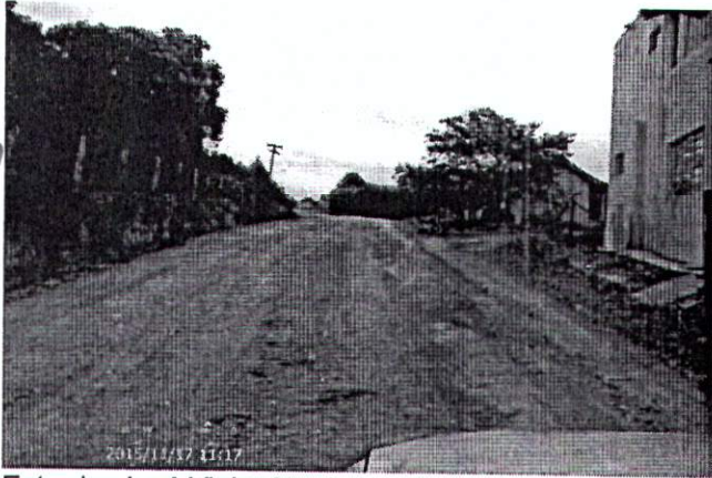
Estrada: José Vieira Machado / trecho: B1
